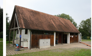
Sanitärgebäude mit Wasch-/Dusch- und Toilettenräumen
